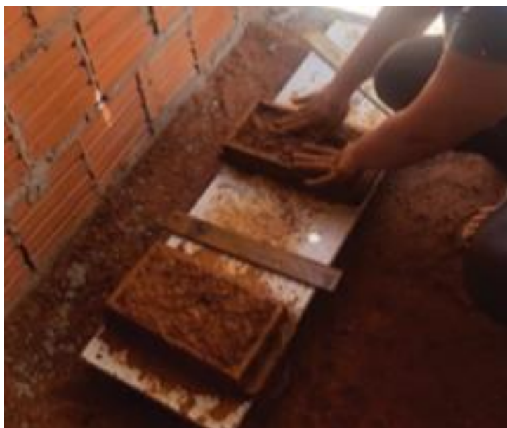
FIGURA 4. Produção de blocos de adobe: regularização e uniformização da superfície na forma. FONTE: Giraldelli, Melo, Pereira, Domingues, Pinheiro e Brasil, 2020
