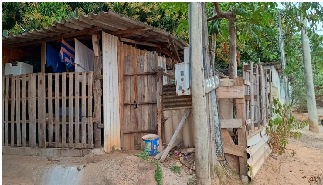
FIGURA 1. Casa na Rua Conde Francisco Matarazzo com tábuas de madeira tapumes de metal. FONTE: próprio autor.
