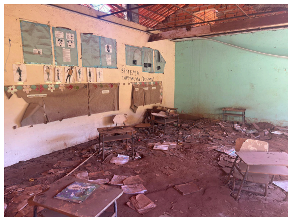
Figura 04: Interior da escola.
