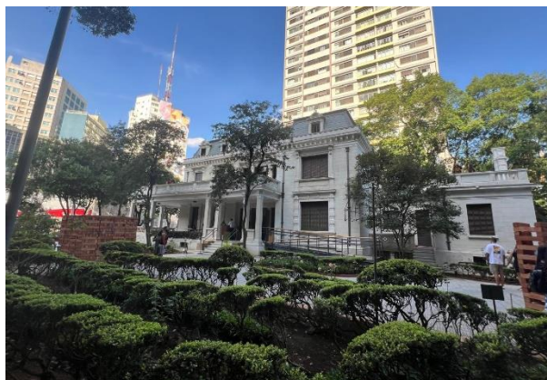
FIGURA 3. Fachada da Casa das Rosas. Fonte: autores, 2024
