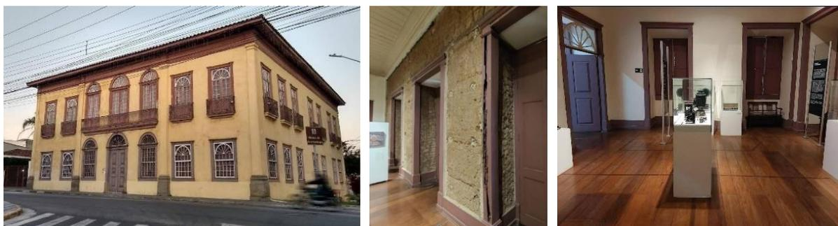
**Figura 4 (à dir.):** Fachada principal do MAV, destacada por sua grande porta e janelas que rodeiam o prédio. **Figura 5 (centro):** Parede sem revestimento, revelando a construção em taipa de pilão. **Figura 6 (à direita):** Uma das salas de exposição do museu, que apresenta uma mostra sobre a evolução tecnológica. Na imagem, é possível ver os expositores e painéis informativos. Fonte: Fotos gentilmente cedidas por Raquel Arruda Policarpo.
